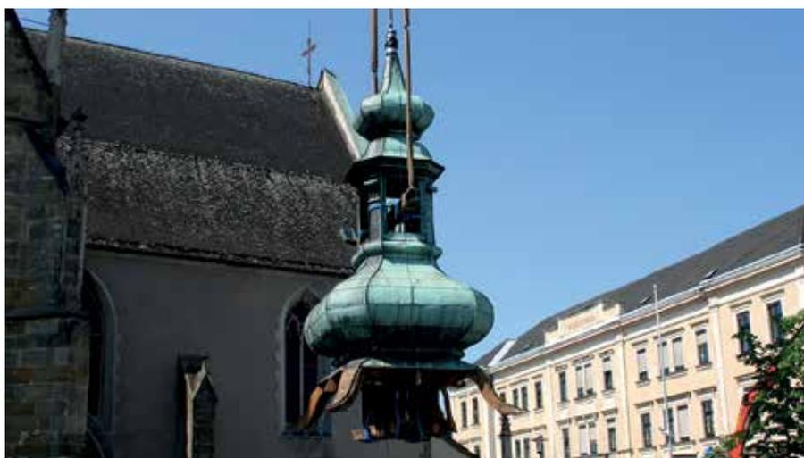
Das absturzgefährdete Turmkreuz wurde bereits im Vorjahr in gerüstloser Technik am Seil abgenommen. Zur Abnahme und späteren Wiederaufsetzung des Turmhelmes, dessen Dachstuhl komplett erneuert wird, musste ein 200-Tonnen-Kran einge-
