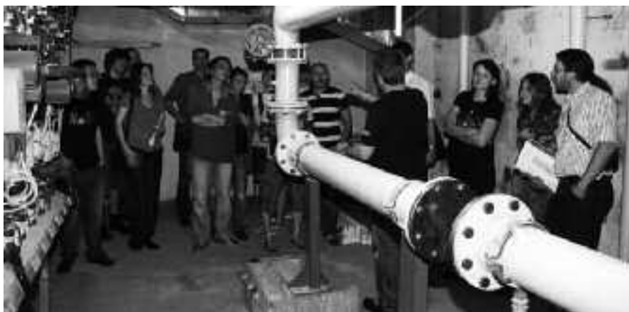
Kellerführung in der Ennser Stadthalle
