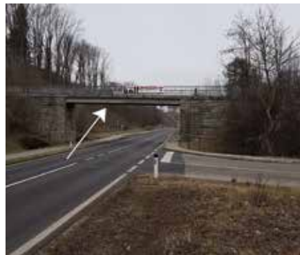
Die Brücke Hiesendorf über die Landesstraße muss für Sanierungsarbeiten gesperrt werden.
